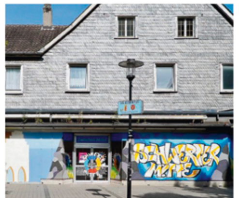
Das neu entstandene Kunstwerk wird noch einige Wochen erhalten bleiben, bevor der Abriss des Gebäudes beginnt.
